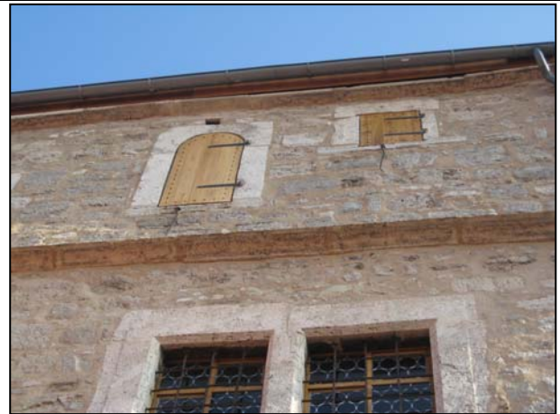
Detail des fertig gestellten Westgiebels
