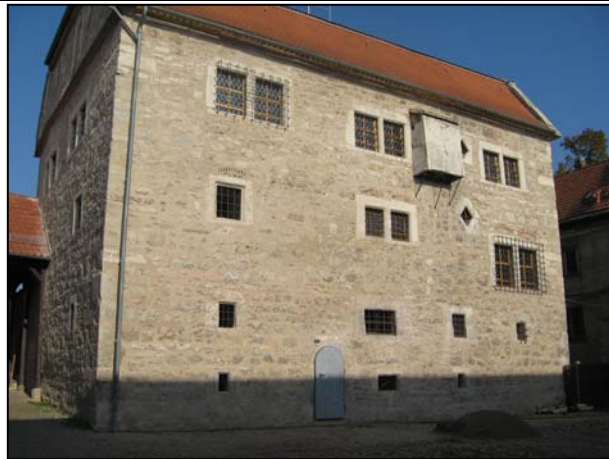
Südfassade nach der Fertigstellung
