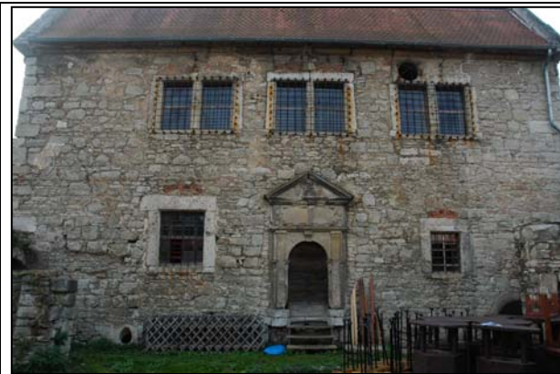
Nordfassade des Komturhofes vor der Sanierung
