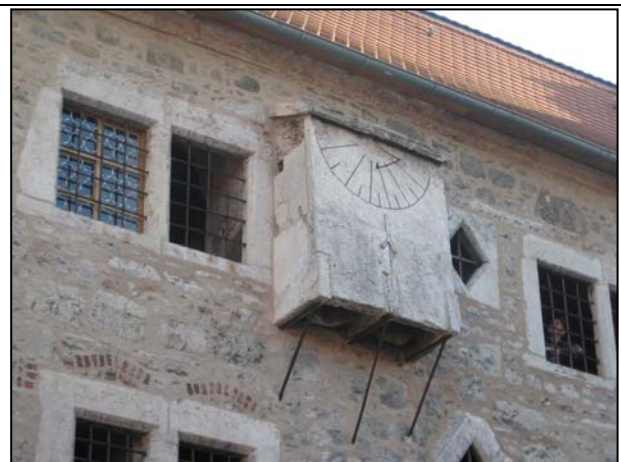
Detail der Südseite mit Aborterker nach der Fertigstellung
