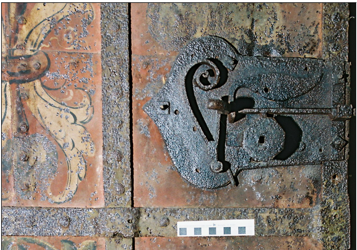
Detail einer Renaissancetür im 1. Obergeschoss
